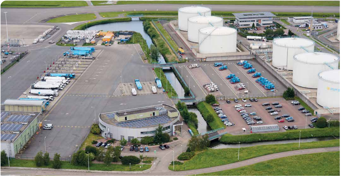
AFS manages the storage and distribution infrastructure of jet fuel at Amsterdam Airport Schiphol. 阿姆斯特丹机场航油供应公司在阿姆斯特丹史基浦机场为航空公司提供航油存储和供应服务。
